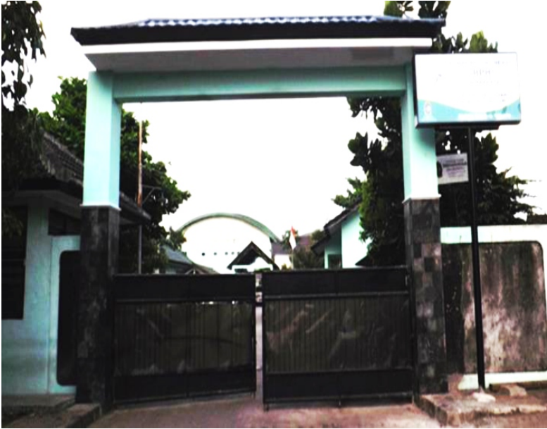
Gambar 8. Rumah Potong Hewan Giwangan, Kota Yogyakarta
